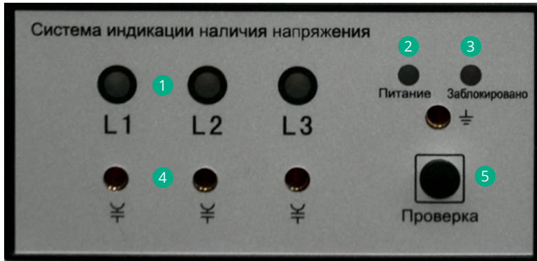
Рис. 7. Индикатор наличия напряжения DXN8D
