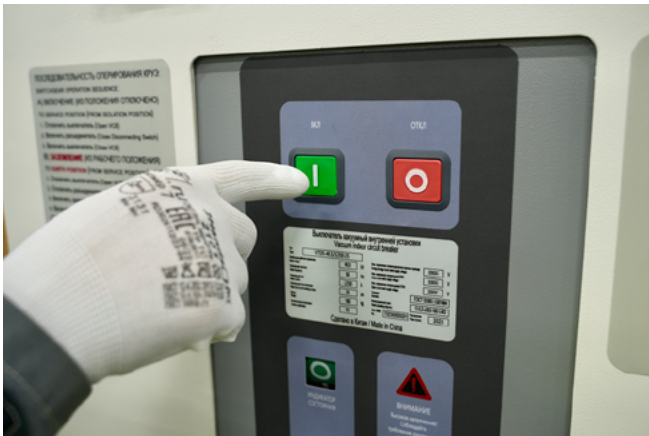
Рис. 16. Включение силового выключателя вручную
