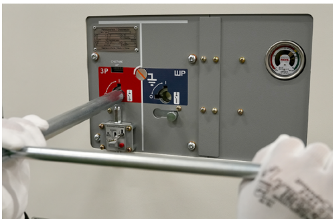
Рис. 21. Управление заземляющим разъединителем сборных шин
