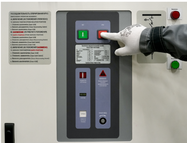
Рис. 17. Отключение силового выключателя вручную
