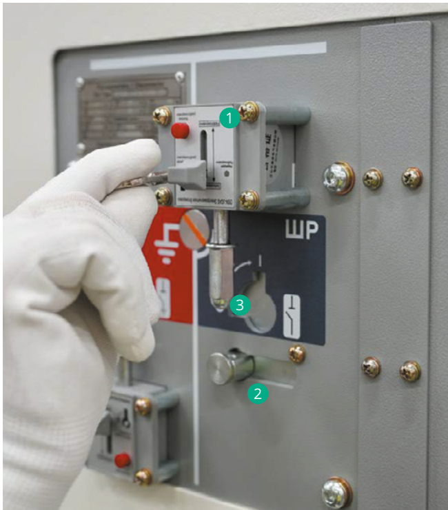
Рис. 18. Блок-замок шинного разъединителя и шиберная заслонка
