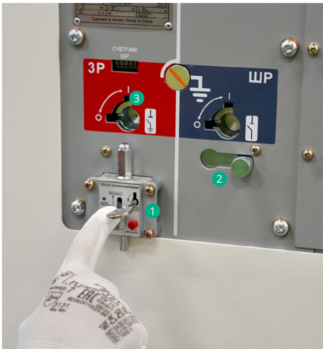
Рис. 20. Блок-замок заземлителя сборных шин и шиберная заслонка
