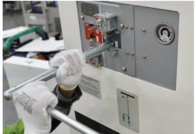
Рис. 19. Управление шинным разъединителем
