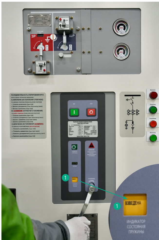
Рис. 15. Ручной взвод пружины привода
