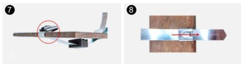
7 Расположите застежку ближе к верхнему краю шины, сделайте оборот вокруг шины, при этом установите по центру резиновую прокладку с нижней стороны шины, а сам датчик - с верхней;
