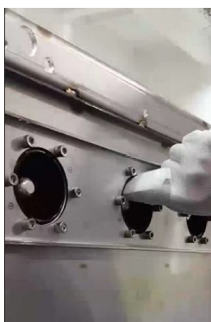
Рис. 25. Очистка изолятора в ячейках слева и справа
