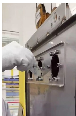
Рис. 25. Очистка изолятора в ячейках слева и справа
