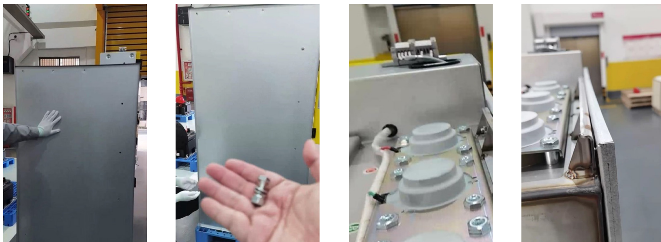
Рис. 31. Установка торцевых панелей
