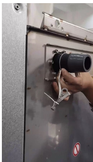
Рисунок 27. Вставка шинных втулок
