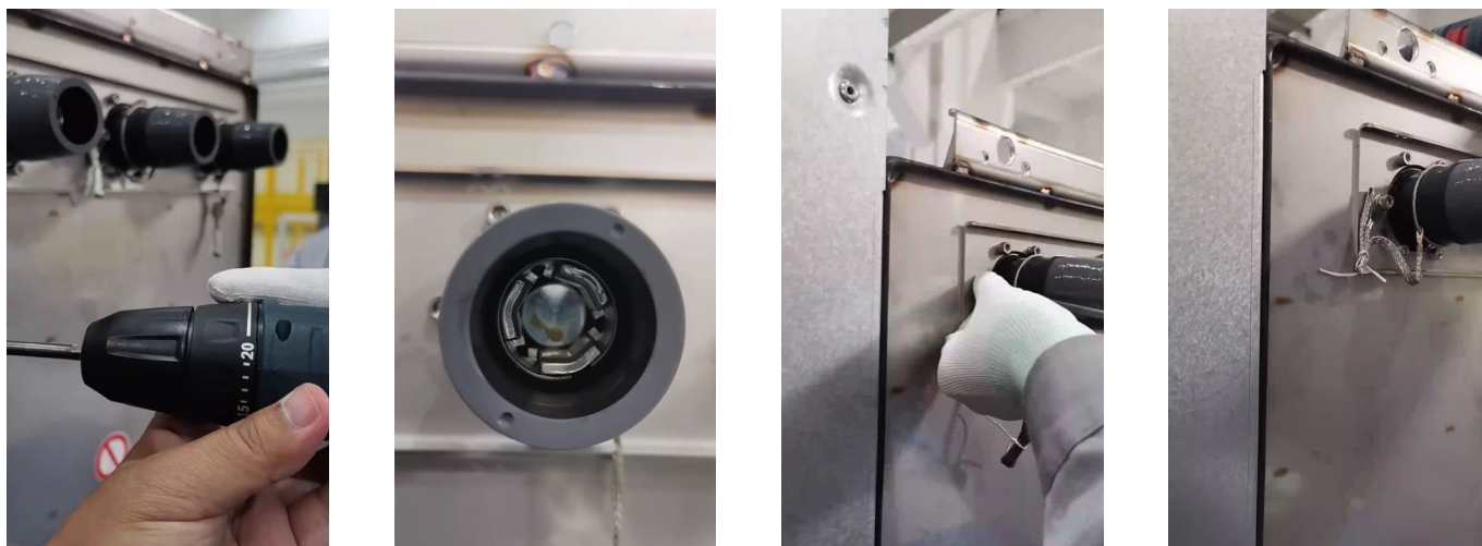
Рис. 29. Соединение заземления втулки с корпусом
