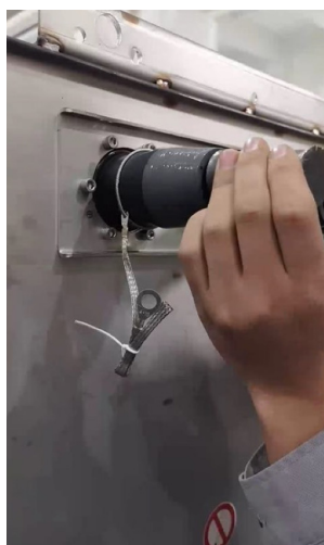
Рисунок 28. Установка втулок в штатное место
